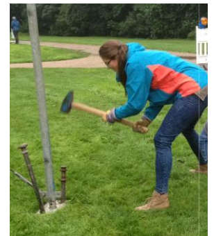
Harte Arbeit – beim Aufbau noch mit Jacke
